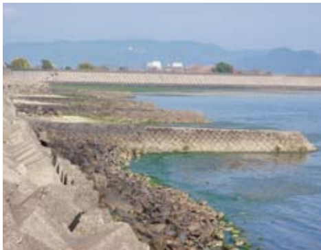
重富海岸の突堤
