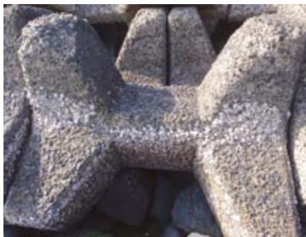
消波堤のブロック
